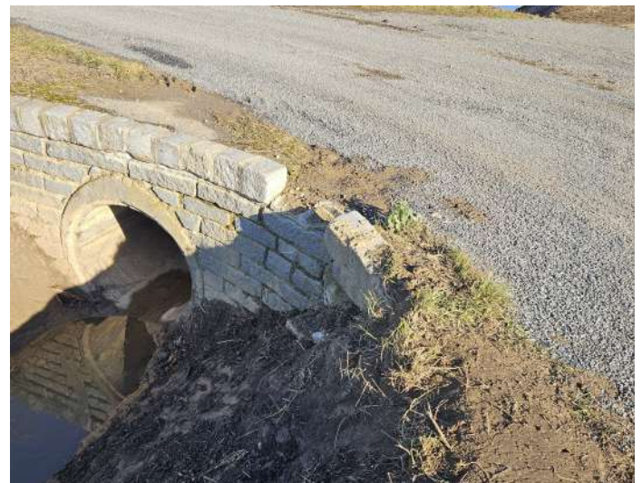
gereinigte Rohrdurchführung
