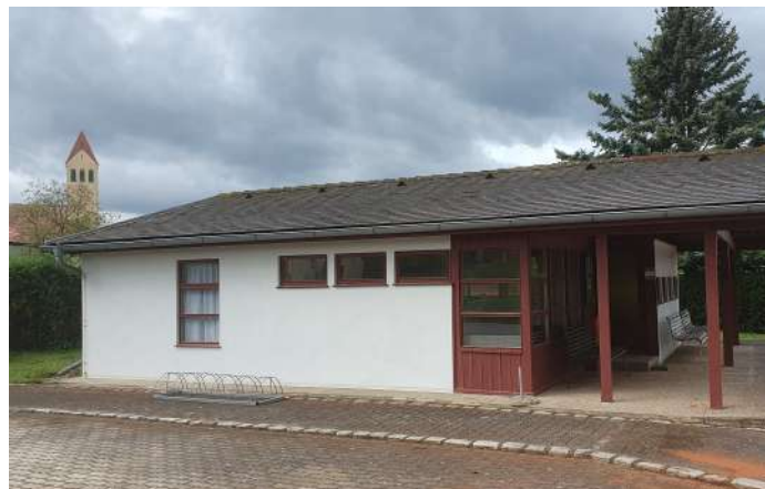
Erneuerung der Fassade
